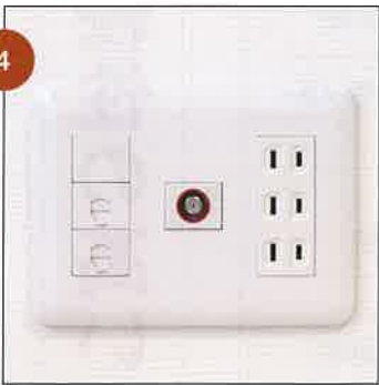
4 部屋の古いスイッチやコンセントプレートを交換する
