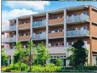
● 重量鉄骨造
