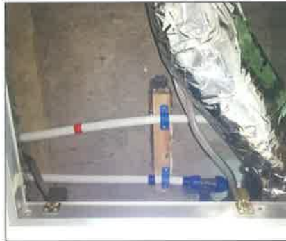
●天井裏点検口から施工
