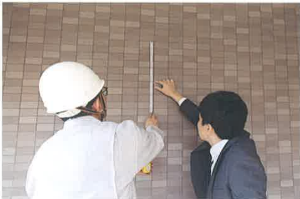
物件の現地調査では共用部の外壁の繋ぎ目、専有部バルコニーや窓枠周囲の壁面の繋ぎ目などを触り「シリコンコーティングに柔軟性があるか」確認するのが理想的です。
