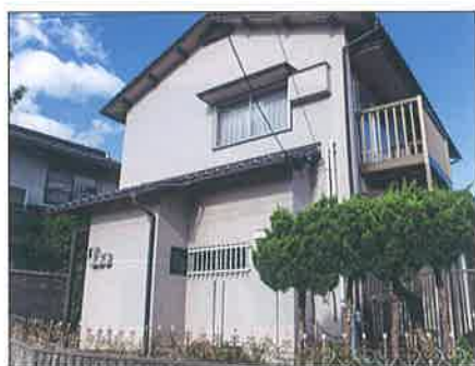
中古戸建てにおいて、修繕費用が高いのが水まわりです。特に配管などに問題がある時は金額が嵩みます。家の傾きや雨漏りなども高リスクです。
