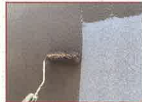
外壁等の修理
