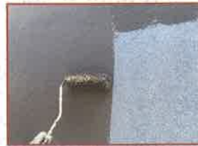
外壁等の修理
