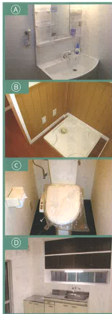
①内見時の印象向上に繋がる750ミリサイズのシャンプードレッサー。②洗濯機パンは比較的安価に入手可能。③温水洗浄便座は有効なアイテムのひとつ。④キッチンの吊り戸棚の扉にダイノックシートを施工した事例。
