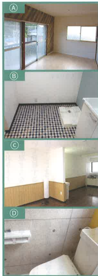
①部屋の一面にアクセントクロスを入れてイメージアップ。②水まわりの床に、タイル調のクッションフロアを採用した事例。③リビングに木目の腰壁調クロスを採用。④コンクリート打ちっぱなし柄のクロスをトイレに用いた事例。
